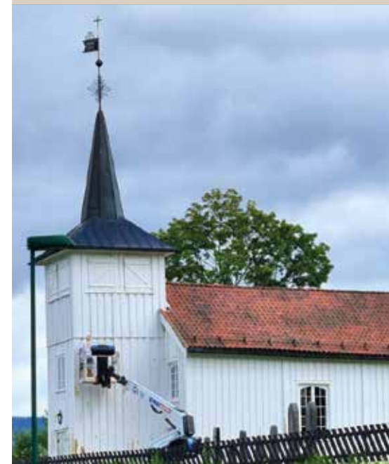
Litt utskifting av bordkledning måtte til, greit å ha ei god stilling å stå i.
