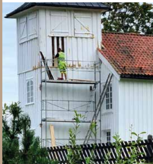
Maling og grunning utføres fra lift.
